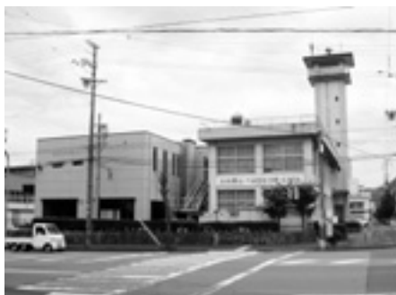
旧福知山消防署跡地
