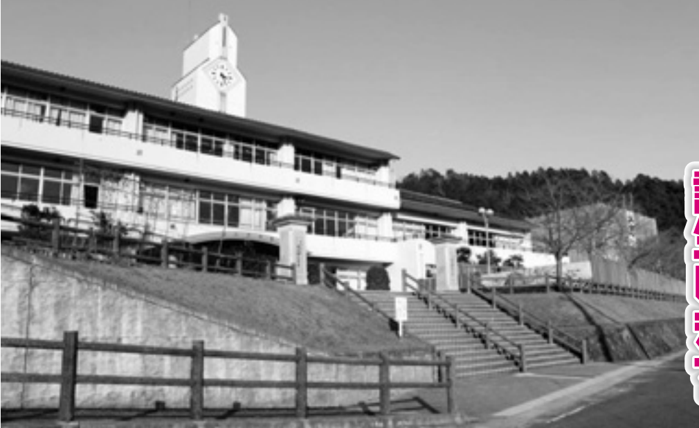
小学校の教室棟の建設(写真右奥)が進む夜久野中学校
