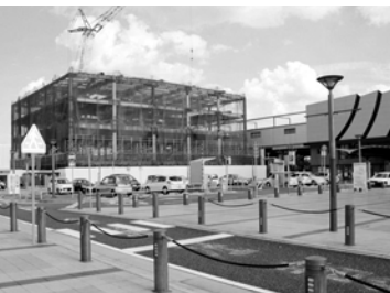
▲建設中の(仮称)市民交流プラザふくちやま
