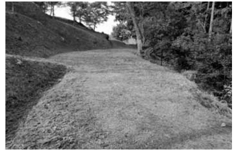
園路の舗装など整備を進めます
