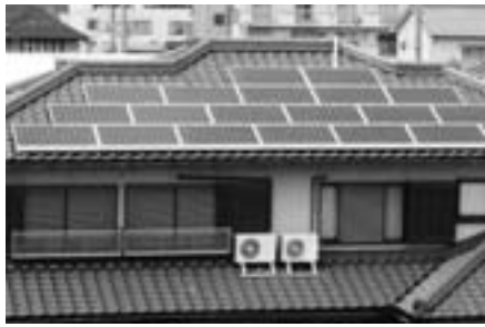
▲太陽光発電システムの設置例
