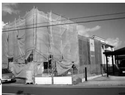
建築ラッシュの戸田分譲地
