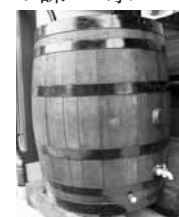
家庭用雨水貯留槽の設置例(治水記念館(下柳町)にて)
