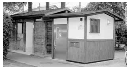
御霊公園多目的トイレ
