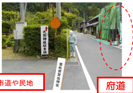
カーブミラーの設置・補修
