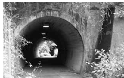
▲②北丹鉄道トンネル跡(公庄上)
