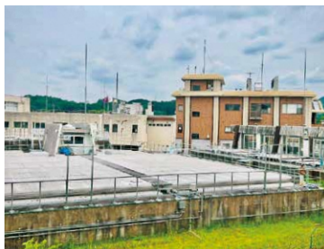
堀浄水場（福知山市水内地内）
