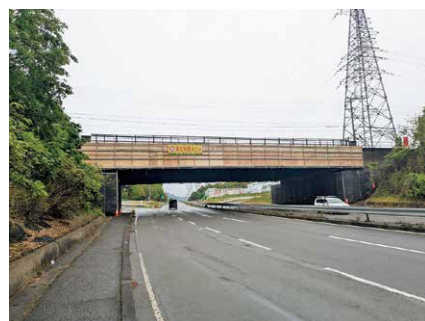
長田野西橋橋りょう補修工事現場 (令和8年4月撮影)
