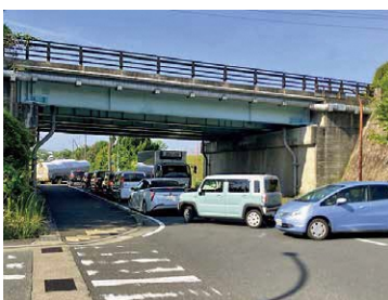
合流しにくいことで渋滞が発生している「市道市ノ谷線」長田野橋下周辺
