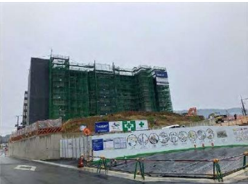
第2期棟(建設中) 北東面
