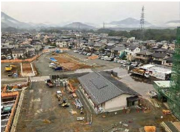
集会所(建設中) 東面
