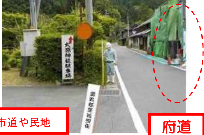
カーブミラーの設置・補修
