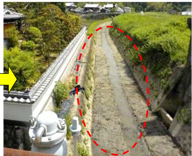
土砂を撤去して河川の流れを確保！
