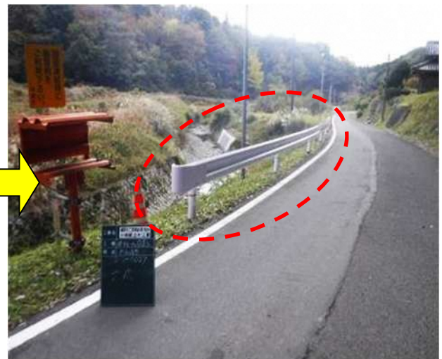
ガードレールを設置して安全を確保！
