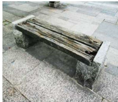
木製施設が腐っている
