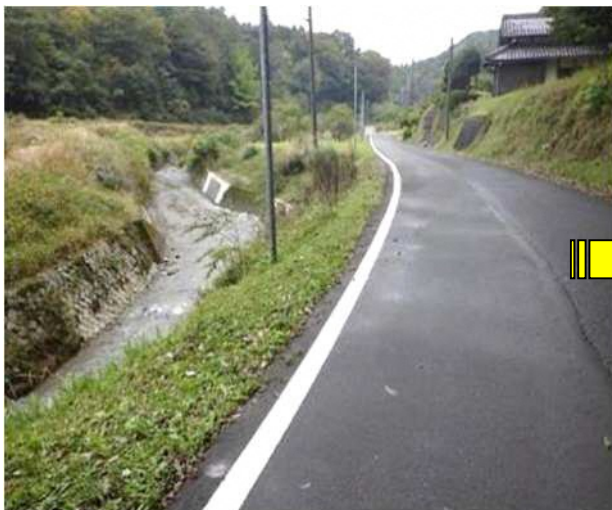
車両などが川に転落しそうで危険
