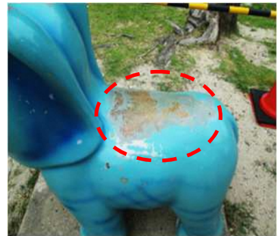
遊具の塗装が剥がれている
