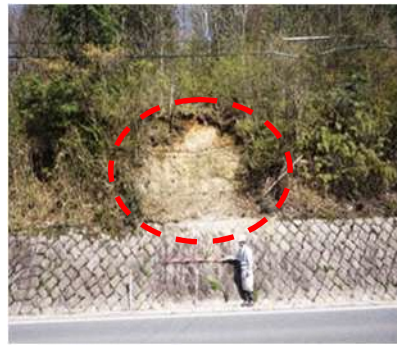
のり面が崩れている
