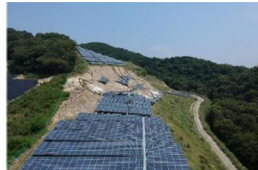
傾斜地の崩壊が発生したため、法肩部分の架台が流出した事例
