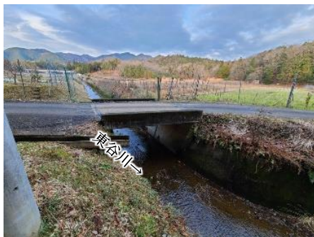
道路拡幅(幅員約4.0m→9.5m)のため、東谷川に架かる橋の更新を実施
