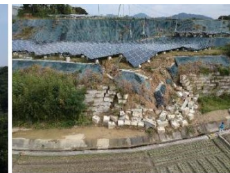
法面保護工が崩れて流出した事例
