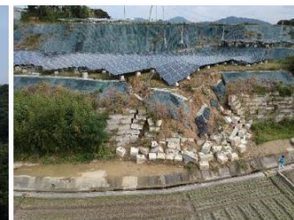
法面保護工が崩れて流出した事例
