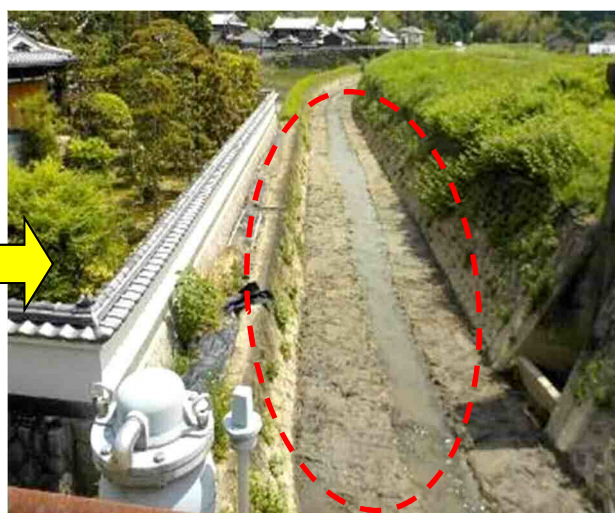
土砂を撤去して河川の流れを確保！
