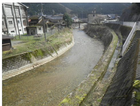
河川堆積土砂の浚渫(しゅんせつ)
