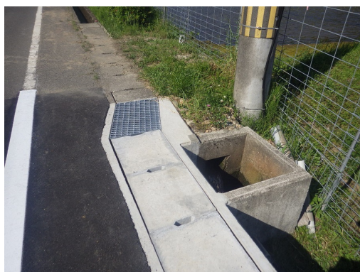
側溝と舗装面の段差解消
