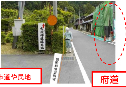
カーブミラーの設置・補修
