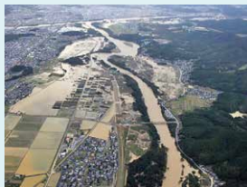
由良川を上空から撮影 (提供：国土交通省近畿地方整備局)
