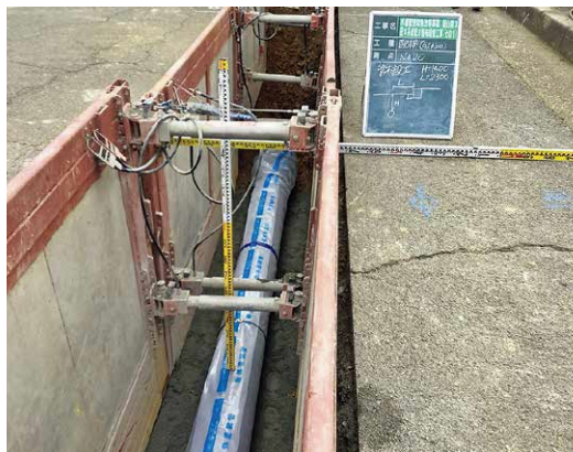
水道管路改善工事
