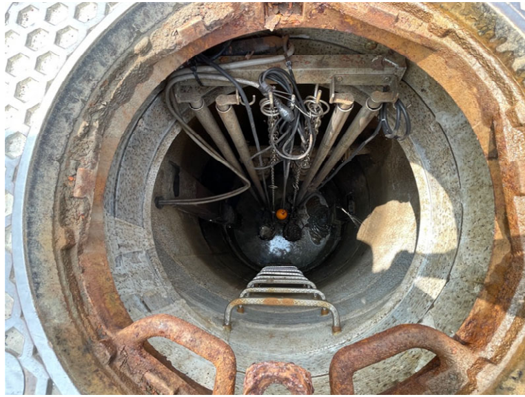
②マンホール槽内
