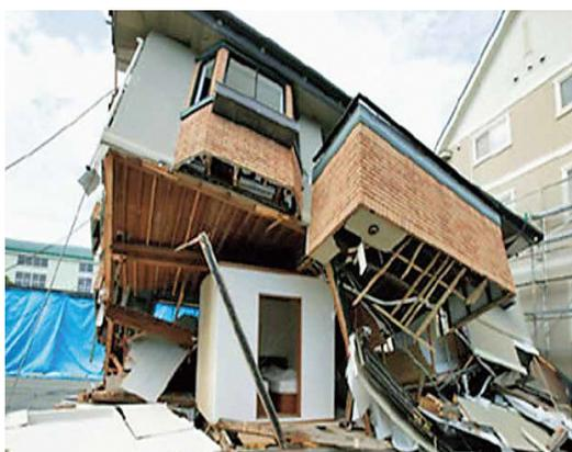
建物が倒壊しても耐え残る耐震シェルター
