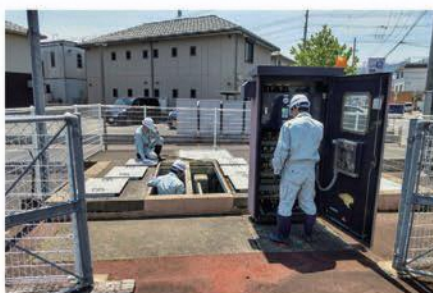
▲駅南排水ポンプ施設点検の様子
