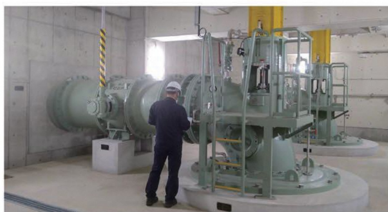
▲機械設備点検の様子
