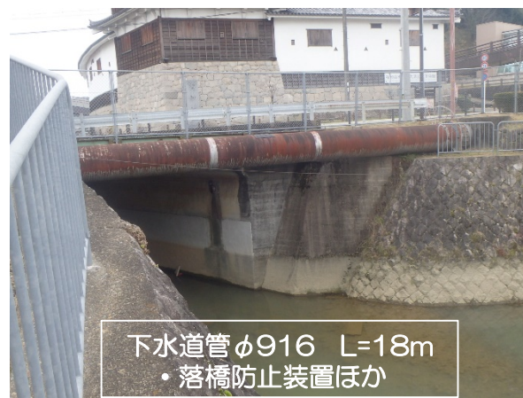
法川水管橋耐震補強工事
