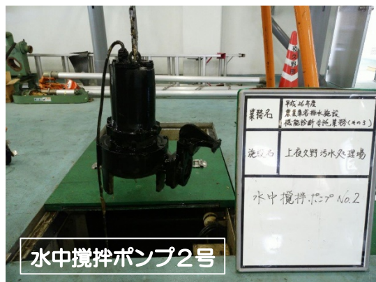
上夜久野污水处理場
