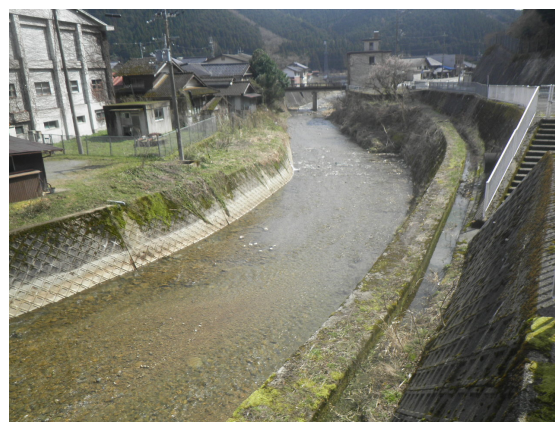
河川堆積土砂の浚渫(しゅんせつ)
