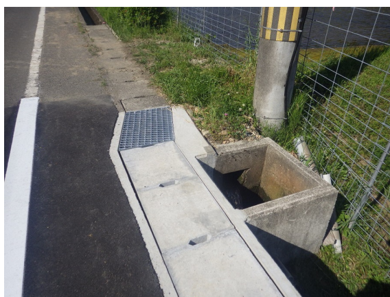
側溝と舗装面の段差解消
