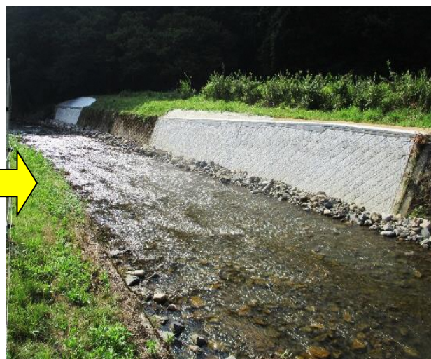
コンクリートブロックで改良！
