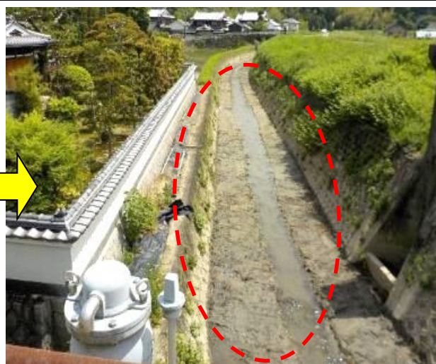
土砂を撤去して河川の流れを確保！
