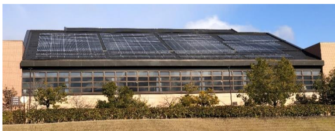
▲三段池公園総合体育館
