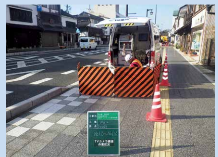
点検・調査の様子
