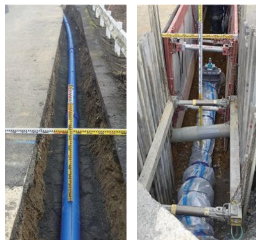
▲新しい水道管(耐震管)を入れている様子 左：ポリエチレン管 右：ダクトイル鉄管
