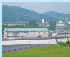
下荒河浄水場
