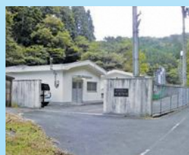
田ノ谷浄水場
