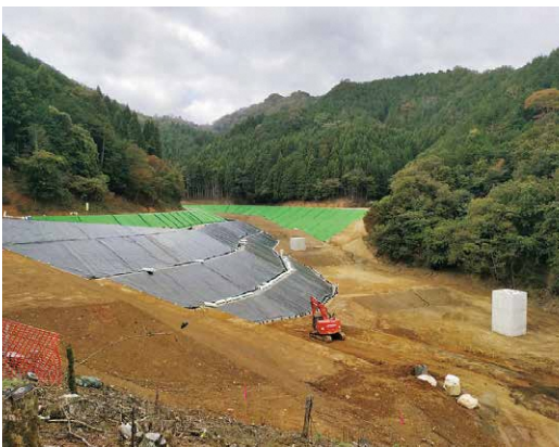
埋立処分場本体の造成工事現場
