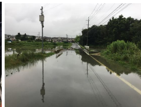
豪雨災害での道路冠水の 状況（H30.7）
