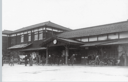
木造の初代駅舎です。左の2階建て部分は増築されました(昭和20年頃撮影)
