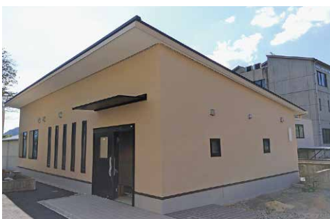
建物内に六人部地域包括支援センター“よりそい窓口”を設置し、地域住民のお困りごとに対応します。
