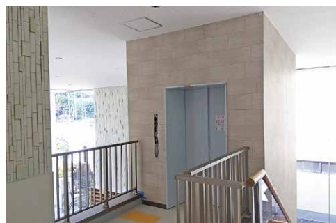
車いすでも2階を利用できるようエレベーターを新設
