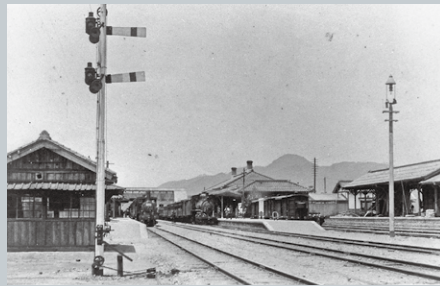
初代福知山駅の構内。手前に見えるのは信号機です。大きなレバーで操作していました(明治40年撮影)
