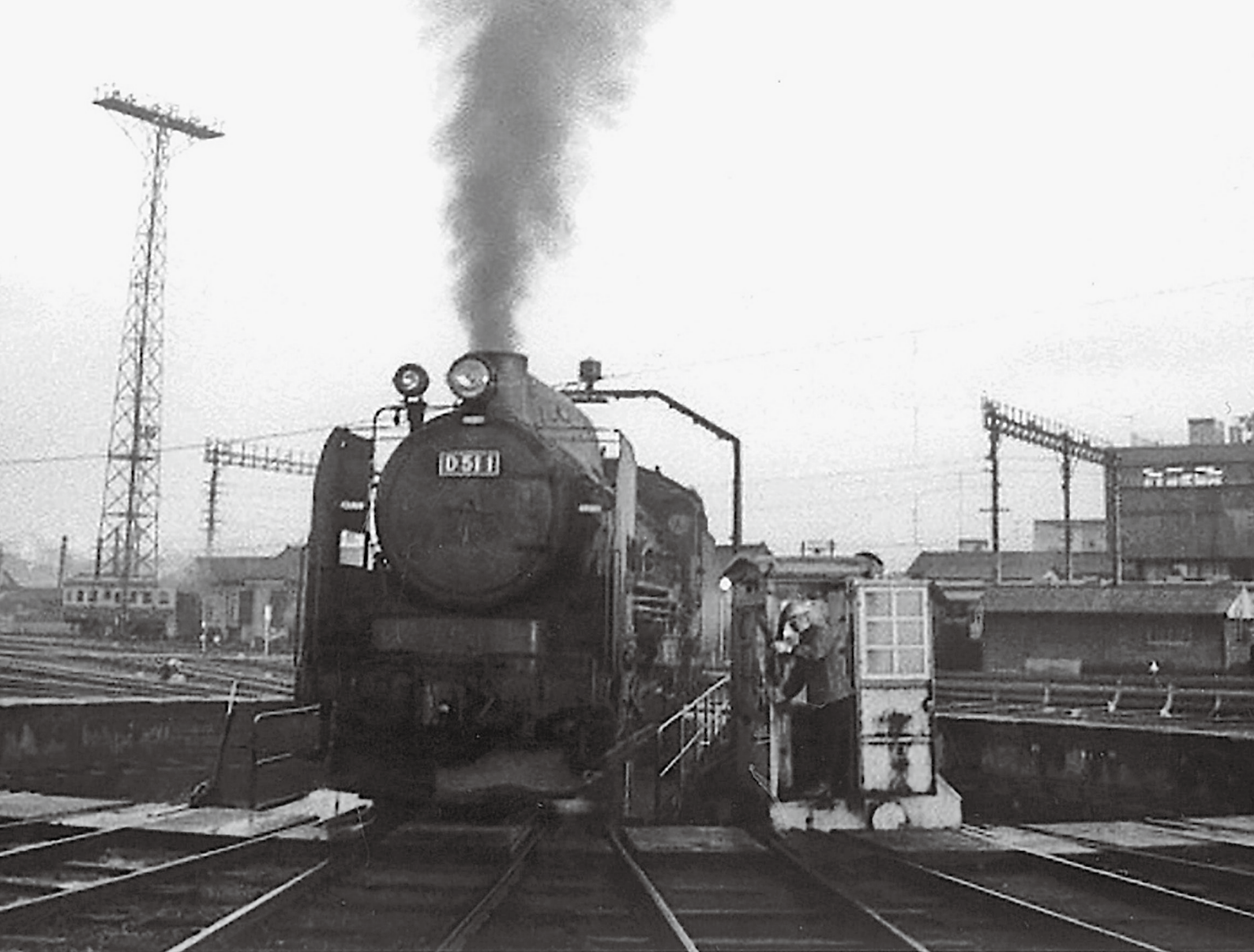
福知山機関区の転車台とイベント列車でやってきたD51 1 (昭和47年 大地洋次郎さん提供) 写真にある転車台は、駅の南口に展示されています。
