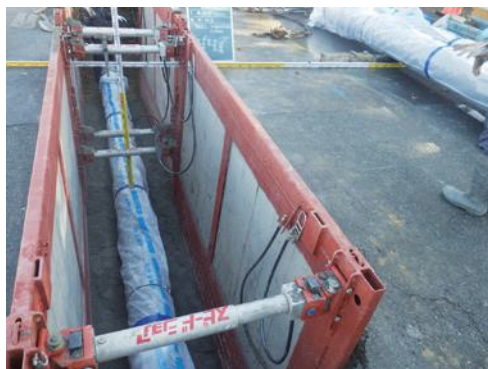
▲堀山第3配水系統配水管布設替工事
