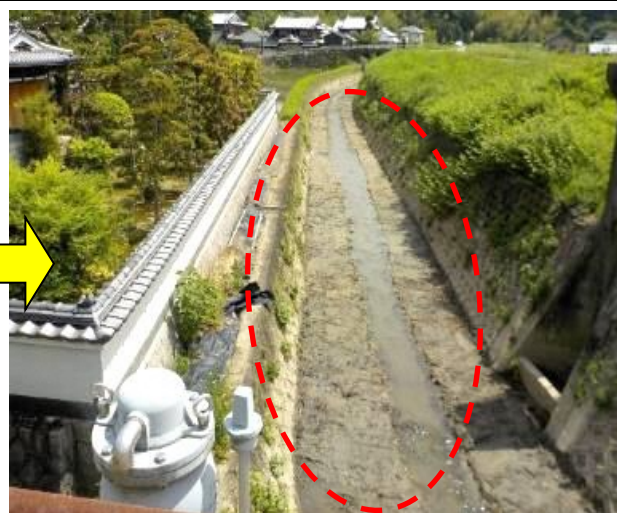
土砂を撤去して河川の流れを確保！
