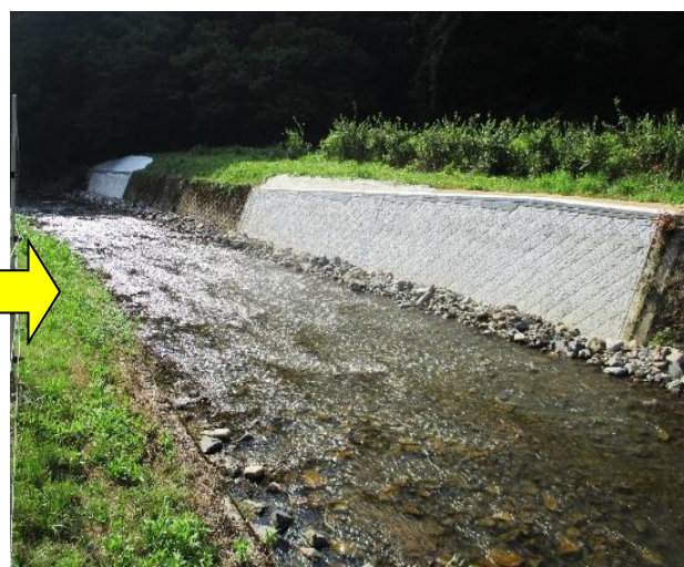
コンクリートブロックで改良！
