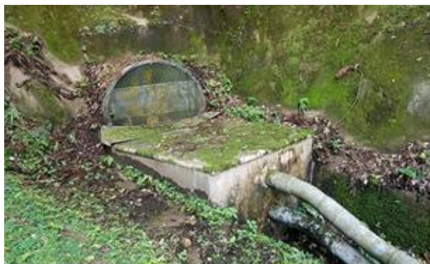
旧福知山鉱山 第3坑口
