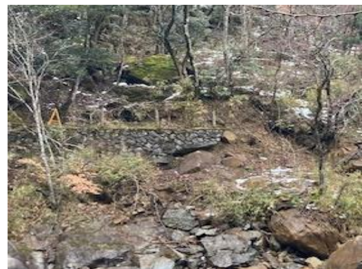
崩落した二瀬川遊歩道
