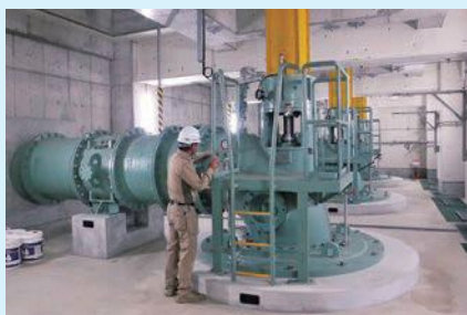
▲段畑雨水ポンプ場内の機械設備点検
