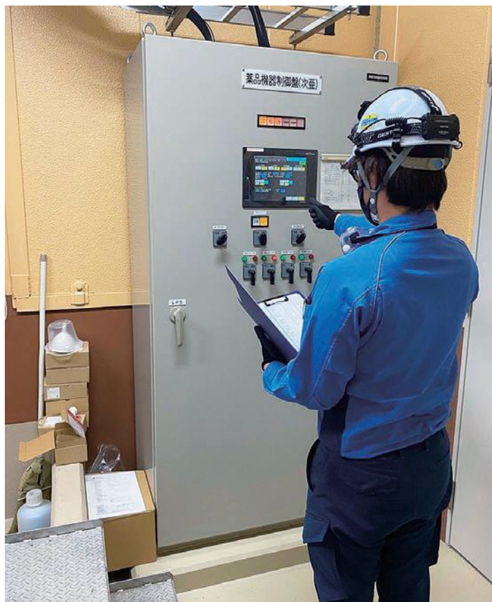
▲施設点検の様子
