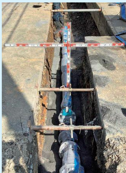
▲耐震管(ダクタイル鋳鉄管)への布設替え
