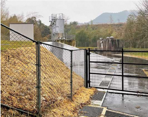
活性炭除去装置設置予定の芦洲浄水場
