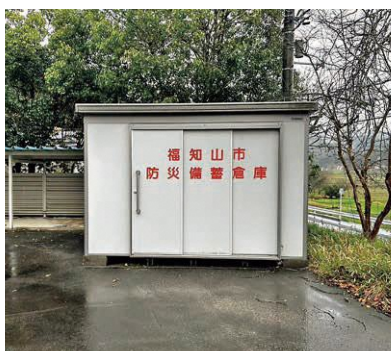
防災備蓄倉庫（有路下体育館）
