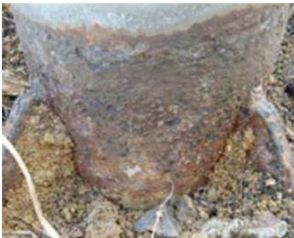
□標識柱の根元が錆びている
