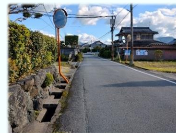
道路排水施設の改良
