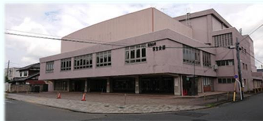
老朽化が進む厚生会館 (基本計画での建設予定地)
