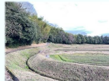
下水道雨水排水路の新設
