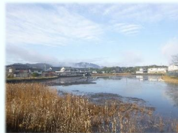
ため池浚渫（砂子池）
