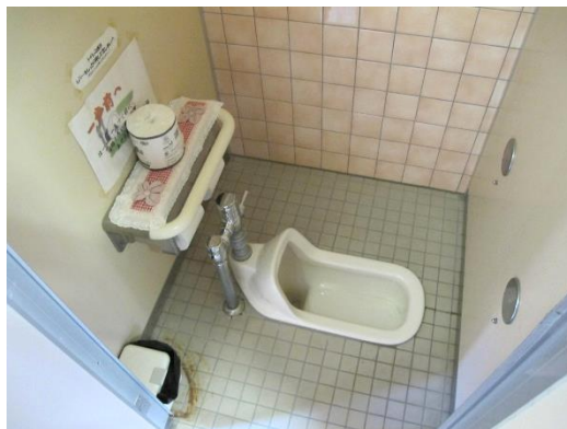
三和中学校 教室棟 便所（現況）
