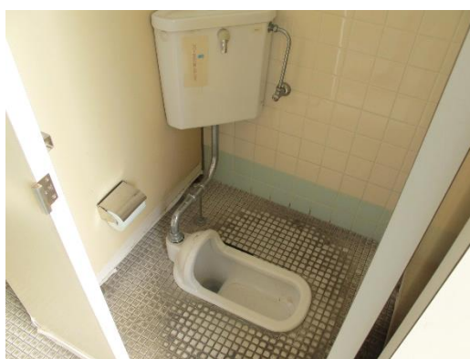
六人部小学校 管理棟 便所（現況）
