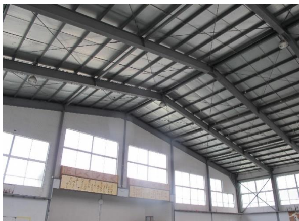
雀部小学校体育館(現況)
