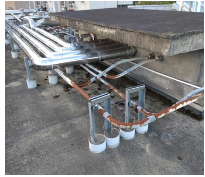
老朽化した空調設備（屋上）
