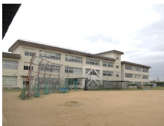
桃映中学校管理棟外壁 (現況)
