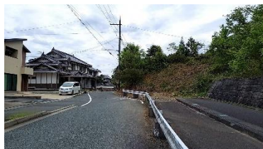
興工区（起点部）
