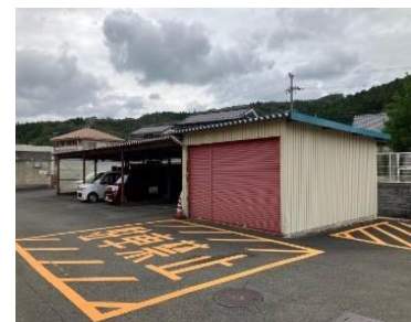
細見分団 消防車庫・詰所建設地 (三和町千束)
