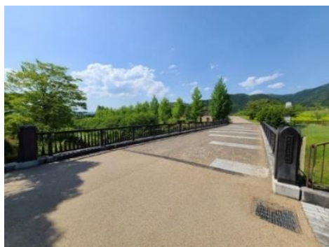
園路改修(三段池公園)
