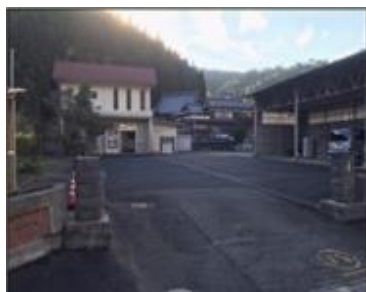
上夜久野分団 消防車庫・詰所建設地 (夜久野町中田)
