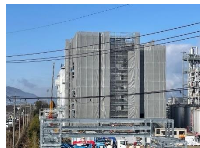
長田野工業団地内の工場増設風景
