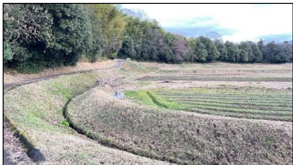
下水道雨水排水路の新設
