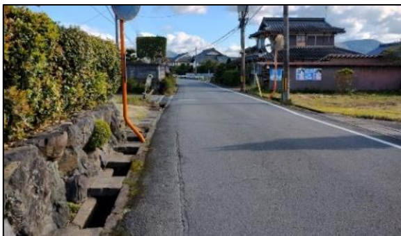
道路排水施設の改良
