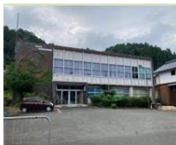
河守分団 消防車庫・詰所建設地 (大江町清水)
