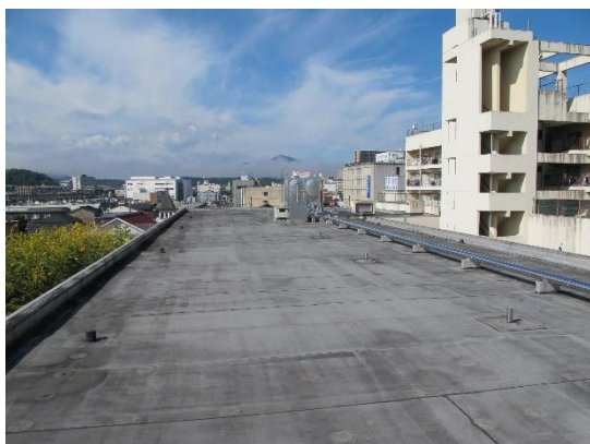
惇明小学校北校舎屋上 (現況)
