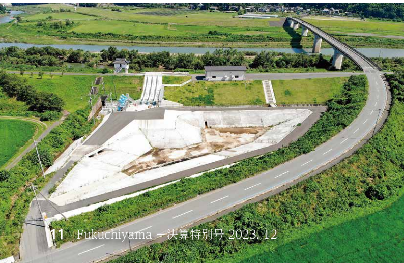
上)消防団員の年額報酬の比較表 左)大江美河橋付近に建設された排水ポンプ施設(令和5年7月撮影)
