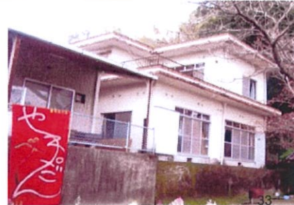
迎賓館 第3号館
