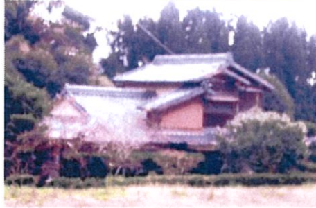
迎賓館 第2号館
