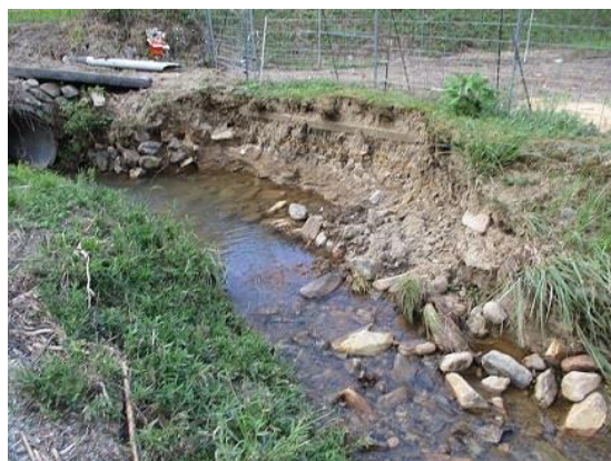
長尾地内 (施設・水路)
