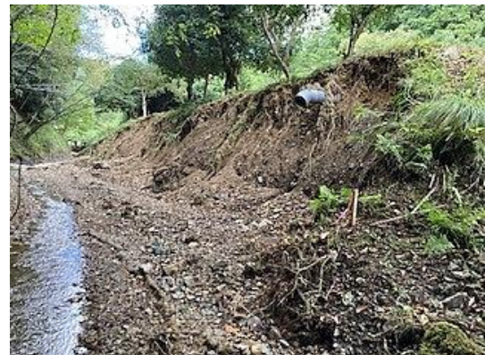
崩壊した駐車場法面の状況
