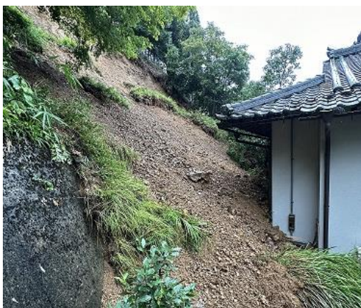
河守地区被災状況
