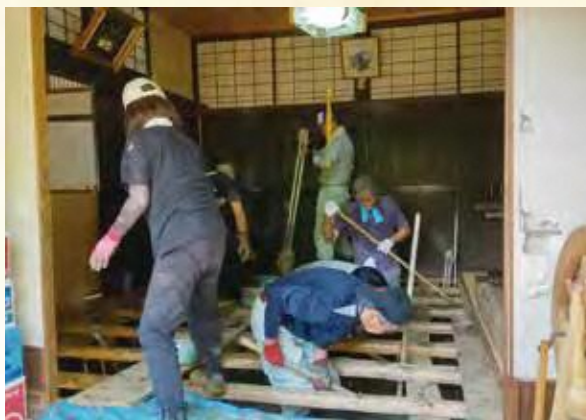
【床下の泥のかき出し】
