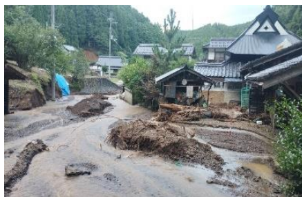
大江町市原谷での被害
